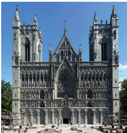
T.v.: Marmorbruddet i Almenningen Romersk teknologi par excellence. Foto: Per Storemyr Over: Vestfronten av Nidarosdomen.
